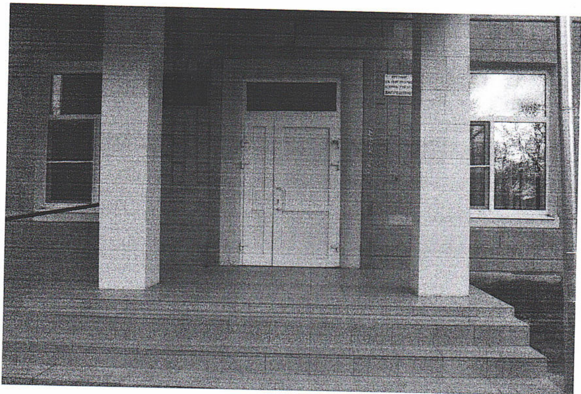
Входная площадка перед дверью №6
